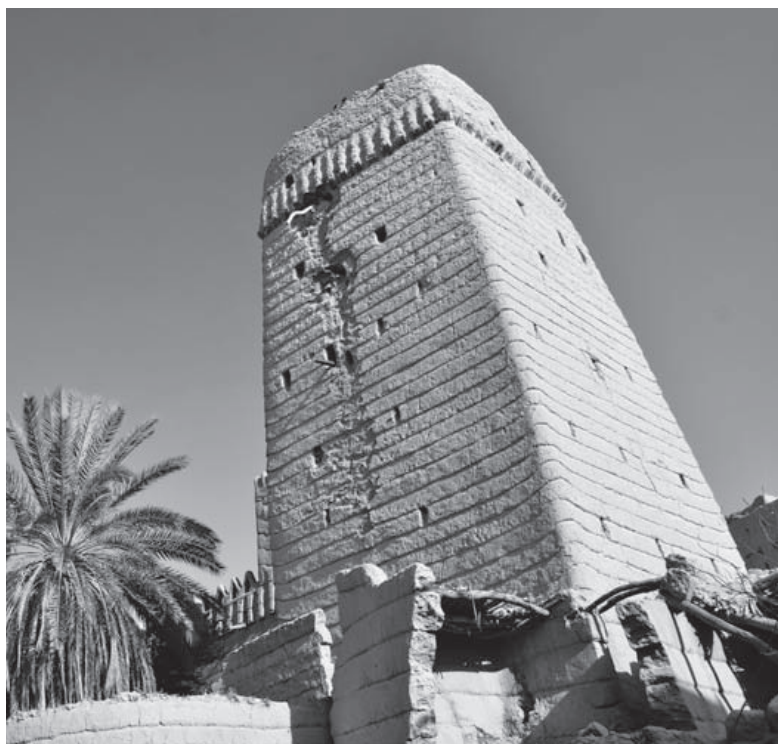
Typická architektúra z nepálených tehál v Najrane
